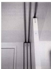
住戸の設計に関しては、世帯ごとに打ち合わせをするので、開取や収納など、自分たちの生活スタイルに沿ったものを実現できる。宮木家では可動式の開仕切りを設置した
